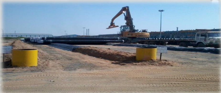
ACOPIO DE TUBERIA CON SISTEMA VACUUM (INDIA)
