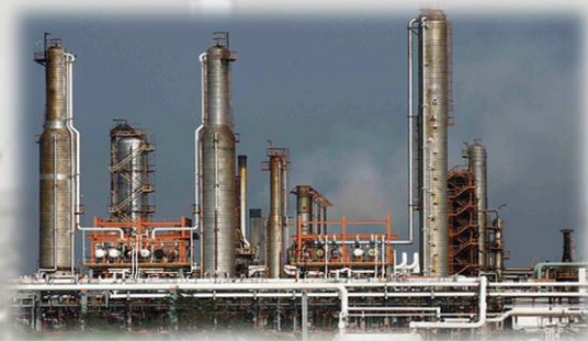
REFINERÍA LAZARO CARDENAS - PEMEX (MEXICO)
