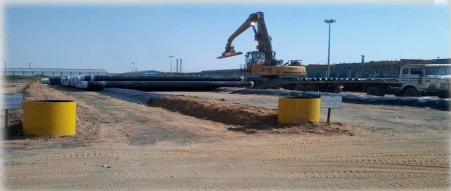
ACOPIO DE TUBERIA CON SISTEMA VACUUM (INDIA)
