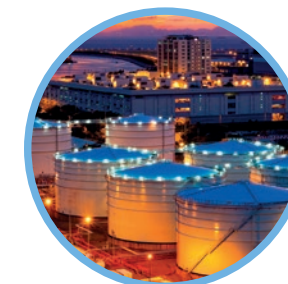
ALMACENAMIENTO DE GAS
