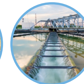
TRATAMIENTO DE AGUA
